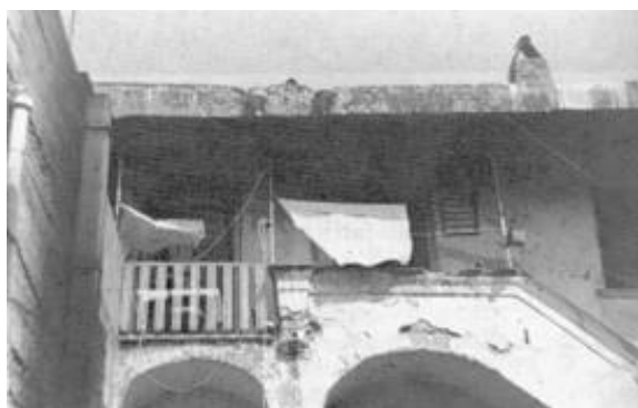
L'interno di corti con il ballatoio su voltine.
