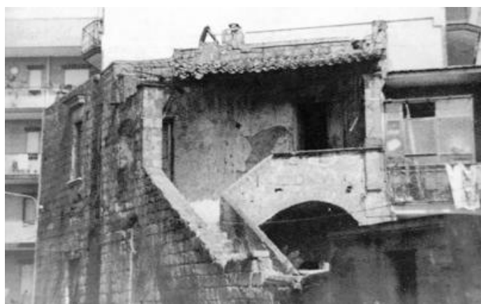
Edificio a corte con ballatoio coperto. La copertura è sorretta da muratura di tufo
